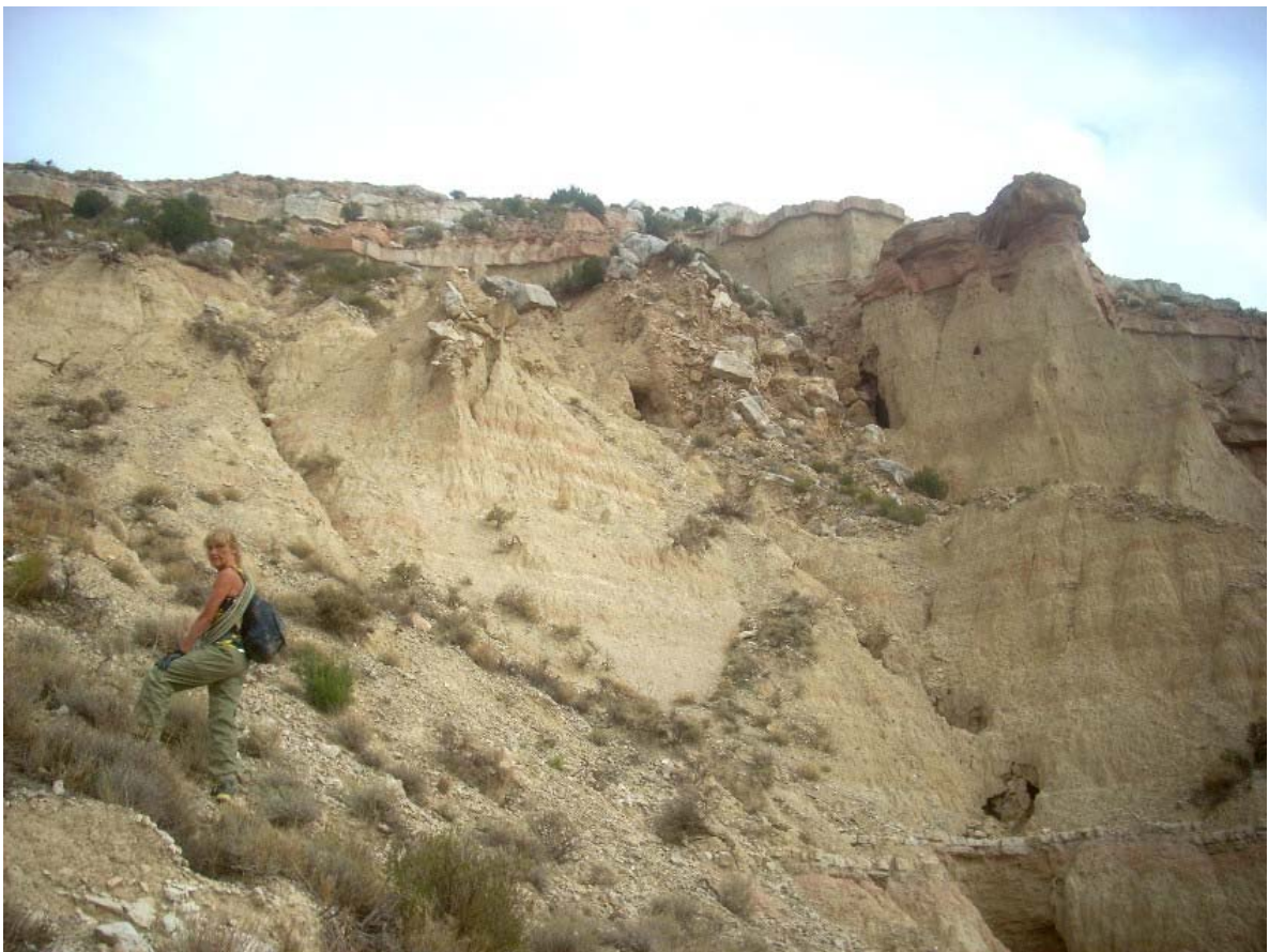
Figura 26. Flanco W de la Nasa Alta (en la zona de cavidades), con un estrato de caliza de 4 m en la parte alta, cuyo colapso progresivo desprende bloques sobre la ladera. Estos y los procedentes de intercalaciones delgadas de otras litologías, forman coluviones junto a los materiales arcillosos predominantes. Su disolución aporta una gran diversidad de componentes que pueden participar en la mineralogía de las espeleotemas halladas en las simas y cuevas.
